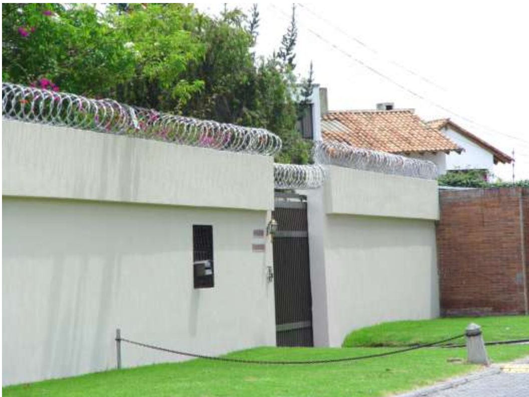
© Photo Fernand Meunier. Maison dans le quartier nord
